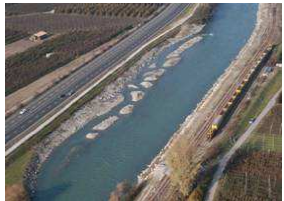
Fig. 35 Allargamenti d'alveo eseguiti sul Torrente Aurino e sul Fiume Adige
