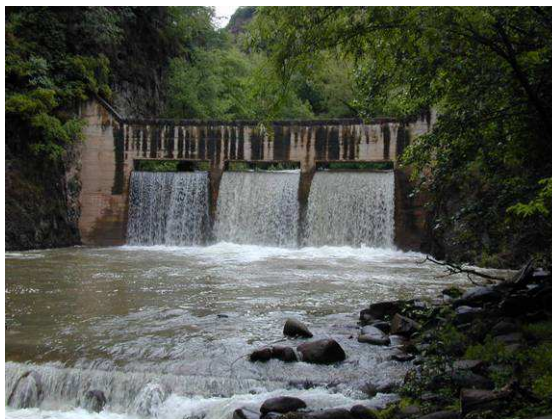
Fig. 29 Opera di regimazione delle acque
