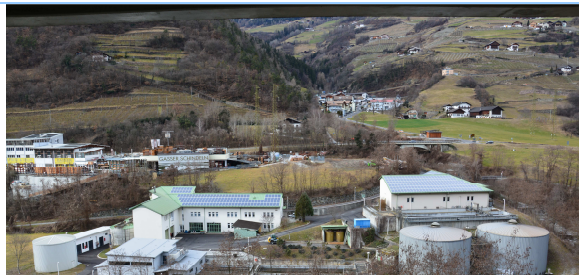
Kläranlage Abbildung (Foto Bezirksgemeinschaft Eisacktal)
