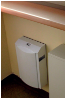
Kontrollierte Frischluftzufuhr erzeugt leichten Überdruck im Raum/Gebäude (innen und außen).
