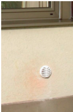
Kontrollierte Frischluftzufuhr erzeugt leichten Überdruck im Raum/Gebäude (innen und außen).
