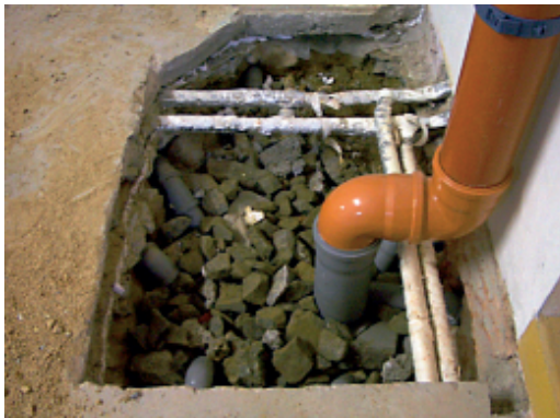
Punktueller Absaugung (Radonbrunnen) – Aushub eines Schachtes.
