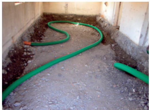
Erneuerung des Fußbodenaufbaues: Einbau einer Radondrainage.
