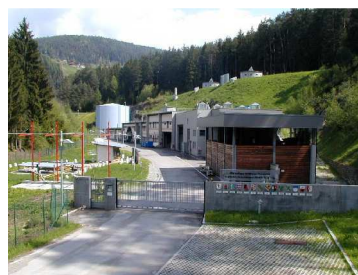
Immagine dell'impianto di depurazione
