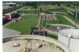
Immagine dell'impianto di depurazione
