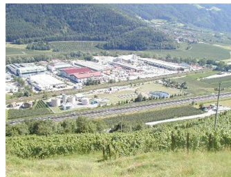
Immagine dell'impianto di depurazione
