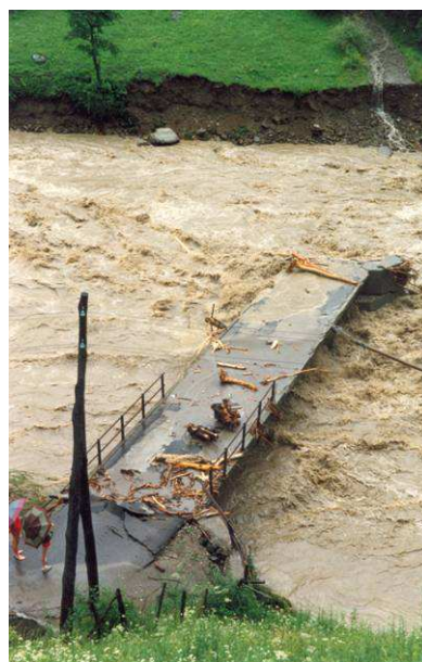
Fig. 68 Un corso d'acqua in piena può provocare gravi danni alle infrastrutture; nella foto il Passirio in piena nel 1987.
