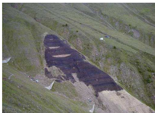
Fig. 82 Opere di drenaggio
