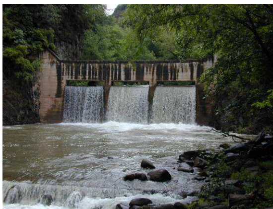
Fig. 110 Opera di regimazione delle acque
