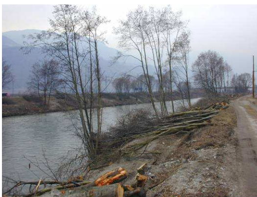
Fig. 72 Intervento di sgombero della vegetazione di sponda
