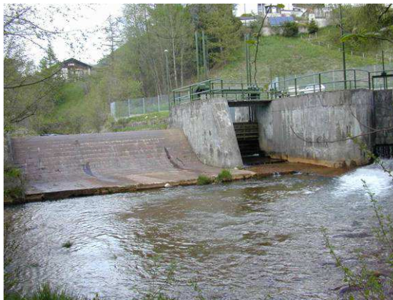
Fig. 111 Opera di derivazione per impianto idroelettrico
