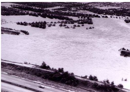
Fig. 67 Rottura dell'argine dell'Adige a Salorno nel 1981
