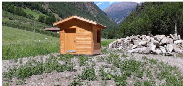
Immagine dell'impianto di depurazione
