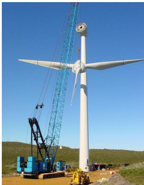
Figura 8 - Sollevamento del rotore secondo le modalità del punto 1
