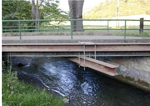
Figura 11 - Esempio di intervento temporaneo sulla strada di accesso al sito per consentire il transito in sicurezza dei mezzi di trasporto (fonte: tauernwind).
