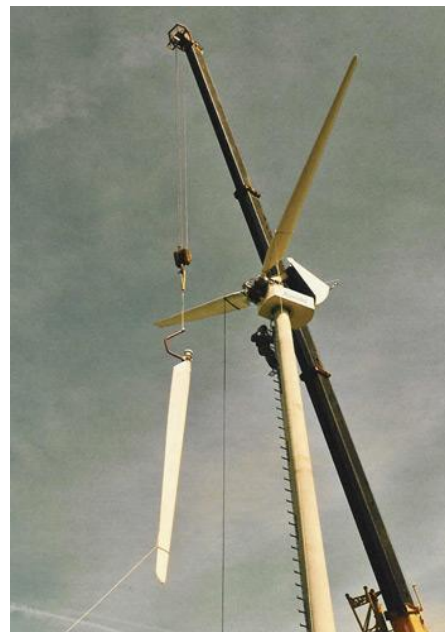
Figura 9 - Montaggio del rotore secondo le modalità del punto 2
