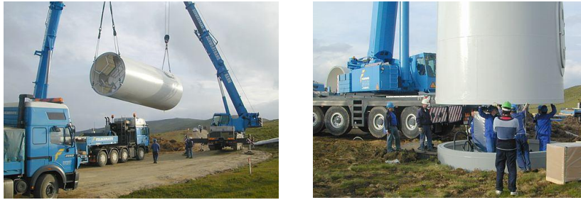
Figura 6 - Fasi di sollevamento (foto a sinistra) e montaggio del segmento di base della torre (foto a destra)
