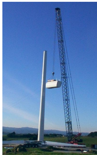
Figura 7 – Montaggio della navicella
