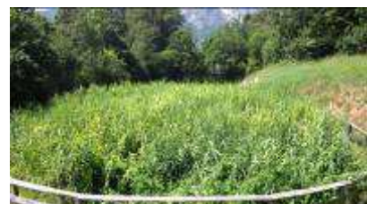
Immagine dell'impianto di depurazione
