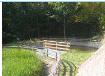
Immagine dell'impianto di depurazione
