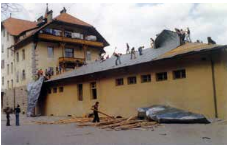
Abbruch des Schlaf- und Speisesaals 1975/76
