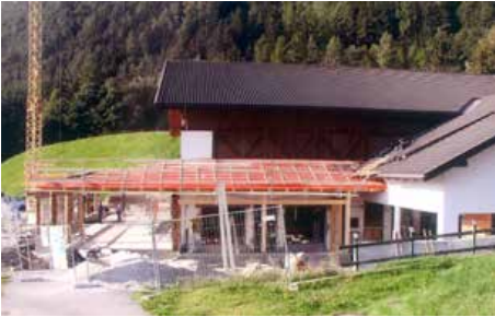
Brugger Hof beim Umbau zum Laufstall
