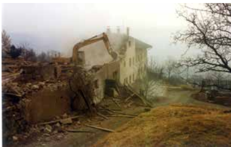
Abbruch des Brugger Hofes
