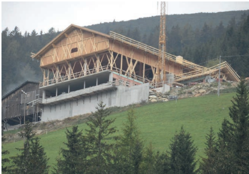
Costruzione di una stalle e fienile
