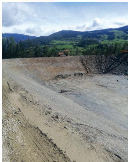
Costruzione di un bacino di stoccaggio
