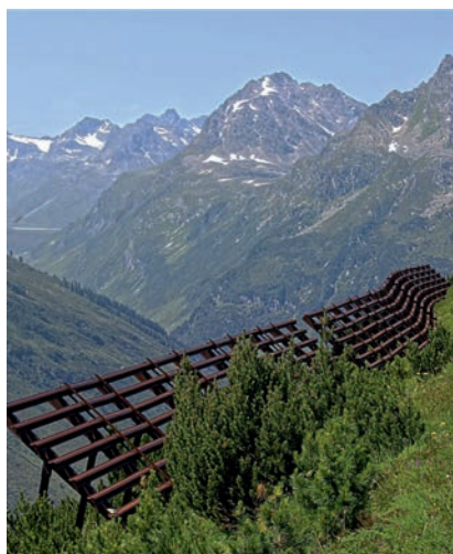
Costruzione paravalanghe in legno e metallo
