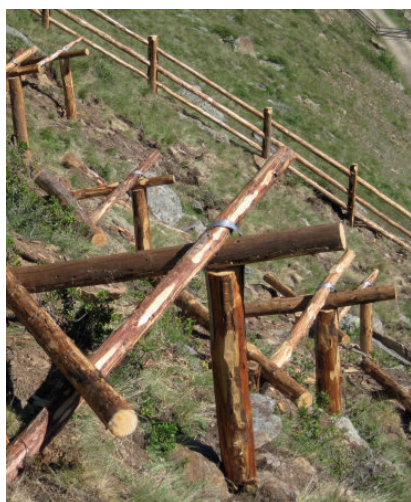
Costruzione di trepiedi fermaneve
