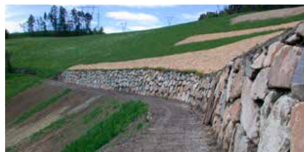
... und nach der Behebung des Unwetterschadens.
