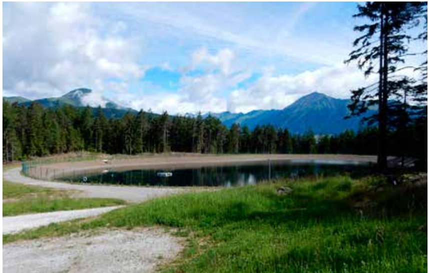
Speicherbecken in Rodeneck
