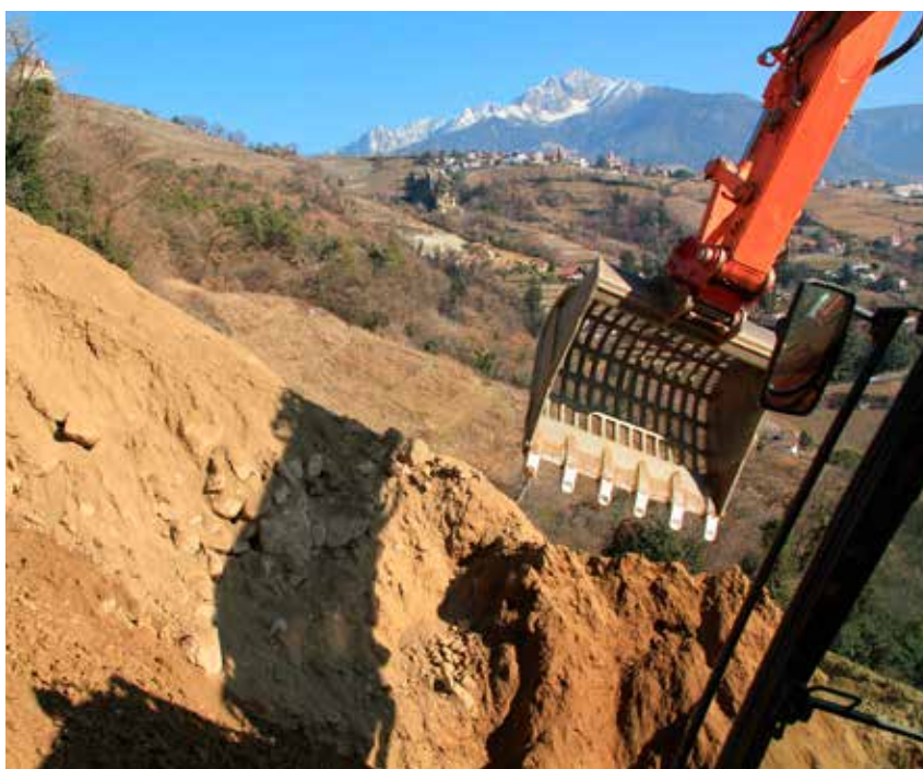
Erdbewegung mit einem Bagger
