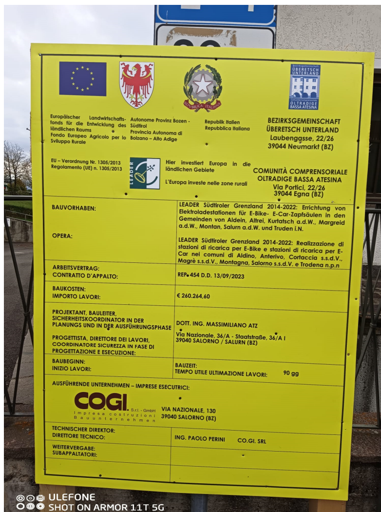
Cartello dei lavori per l'installazione delle stazioni di ricarica per e-bike ed auto elettriche in Bassa Atesina
