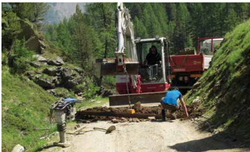
Risanamento strada alpica – messa in opera di un canaletto
