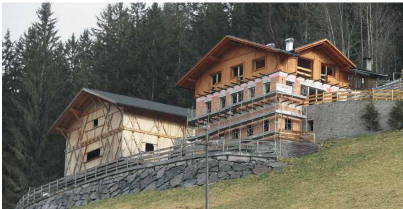
Nuova costruzione stalla e fienile
