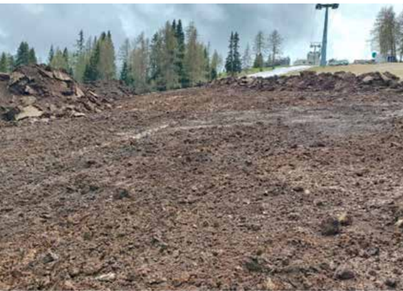
Planierungsarbeiten Skipiste ohne Ermächtigung
