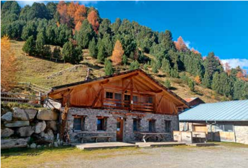
Auf der Laatscher Alm in der Gemeinde Mals wurde im Jahr 2024 der Bau einer Milchleitung (Pipeline) vom Melkstand zum Almgebäude gefördert.
