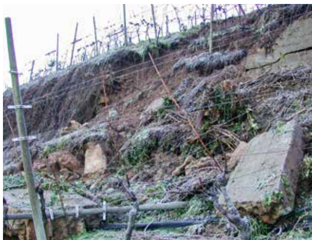
Abbruch einer Stützmauer vor ...
