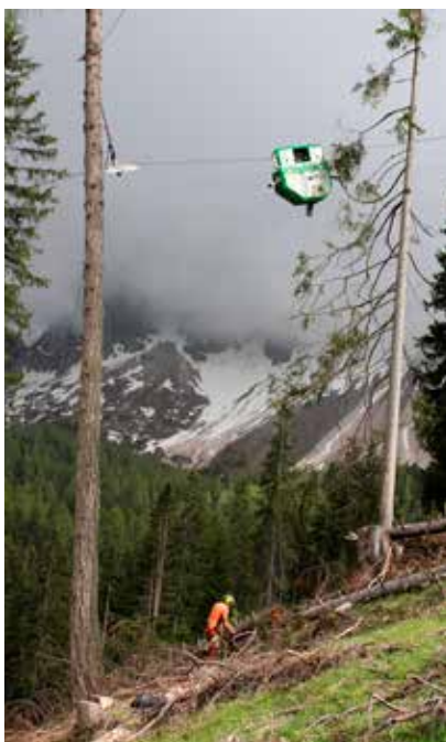
Anhängen der Lasten bei der Seilkranbringung. Der Laufwagen ist elektrisch betrieben.
