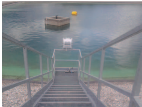
Sistemi di controllo e di troppo pieno del nuovo bacino
