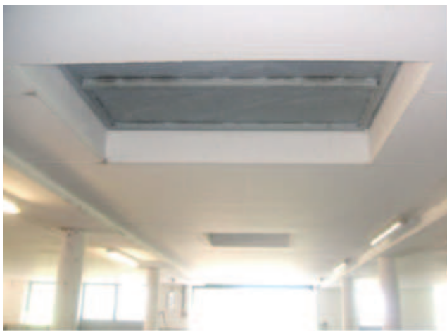
La botola sul soffitto consente di far scendere il fieno per caduta direttamente nella corsia di alimentazione
