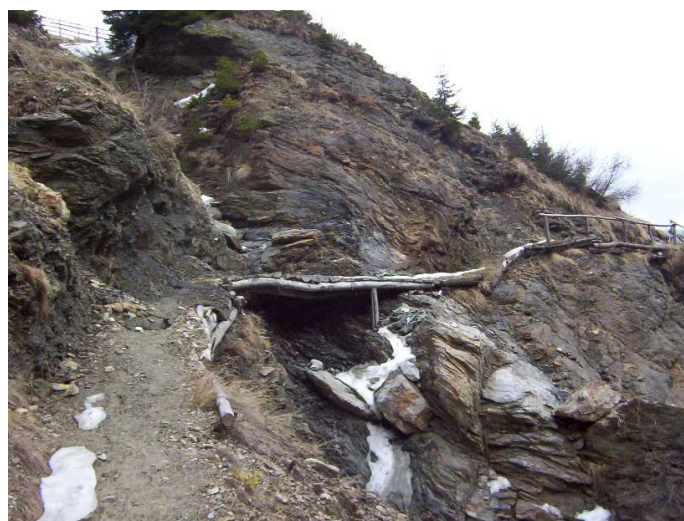
Risanamento via delle leggende
