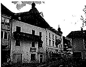
Bar/Pizzeria ("Kuhstall") in zentraler Lage in Gossensaß Scout- ID 50254114 Objekt Nr. 061/09 e
