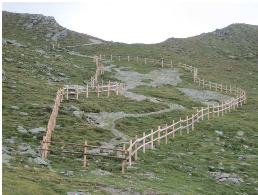
I lavori di sistemazione del sentiero sul monte Peilstein (sopra S.ta Valburga)
