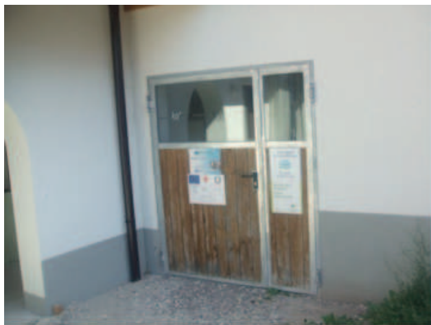
All'ingresso della stalla è messo in evidenza che l'edificio è stato realizzato con contributi CE
