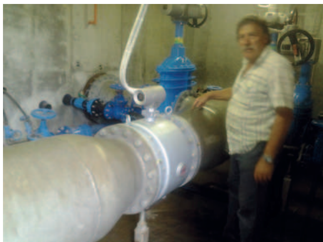
Il secondo lotto del progetto ha visto la sostituzione delle condutture con condutture nuove meglio dimensionate al fine di garantire un'ottimale distribuzione dell'acqua
