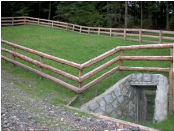
Eingang einer Quellstube und Sicht der Zone I (Foto Landesagentur für Umwelt, Amt für Gewässernutzung, 2013)
