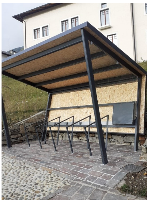
Dettaglio della stazione di ricarica E-bike installata nel centro di Proves
