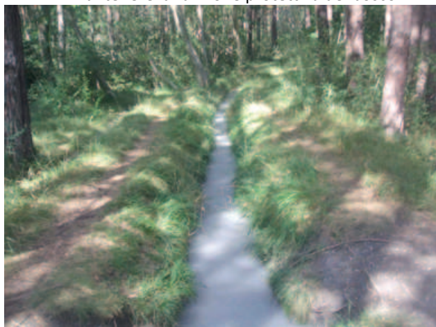
L'intervento ha visto anche il ripristino dei Waalwege. La elevata quantità di limo presente nel Rio Solda tende a depositarsi sul fondo dei canali riempiendoli e rendendo necessari periodici interventi per il ripristino della loro funzionalità.
