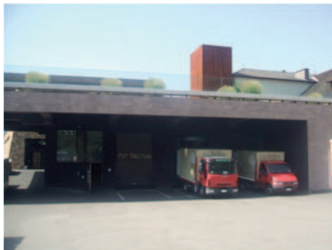
L'area di spedizione e di manovra è stata ampliata
