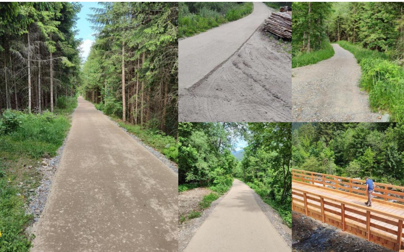
Immagini della nuova pista ciclabile realizzata nel comune di Ultimo
