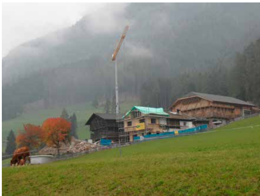
Ristrutturazione di un edificio abitativo agricolo
