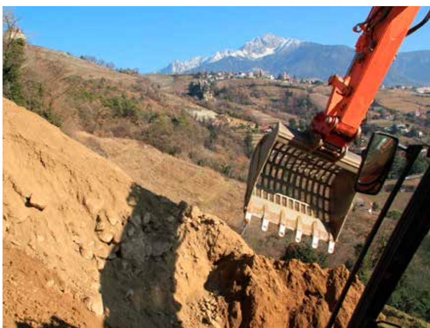
Movimenti di terreno
