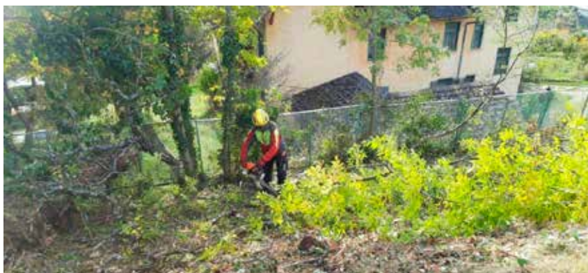
Lavori preparatori per il ripristino di un muro di sostegno
