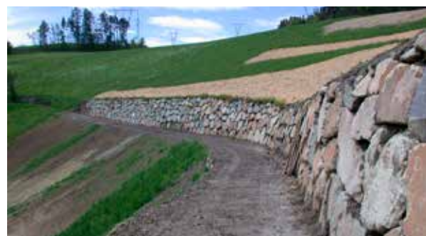
... e dopo i lavori di ripristino
