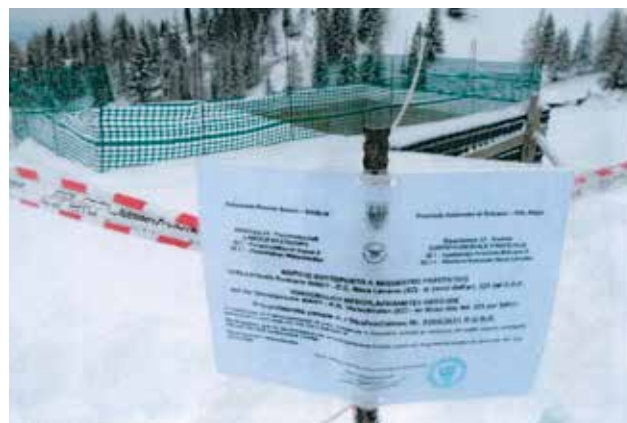
Sequestro preventivo di un cantiere, su disposizione dell'Autorità giudiziaria
