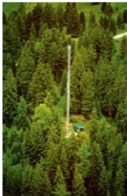
Stazione di monitoraggio a lungo termine di Renon-Selva Verde
