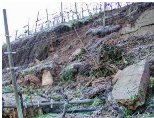
Cedimento di un muro di sostegno prima ...
