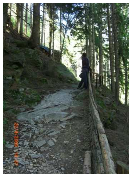
Sanierung Wanderweg Nordheim – Winkler Waldl
