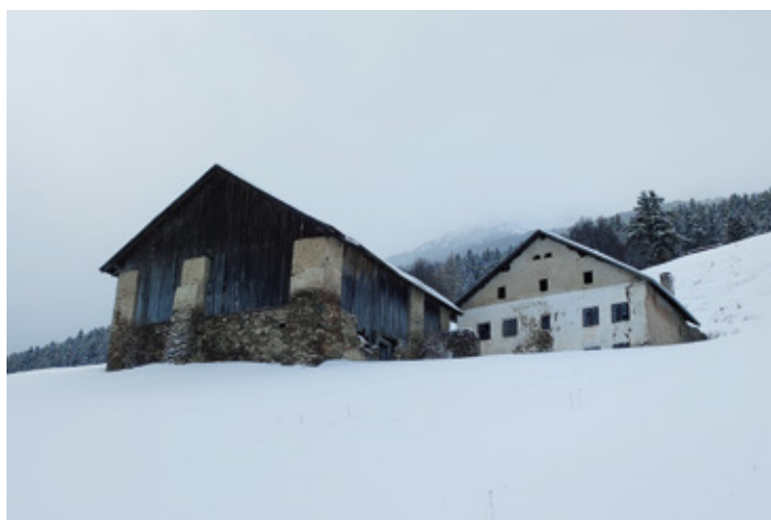
Maso chiuso "Unterspinhof" nel Comune di Curon Venosta →
