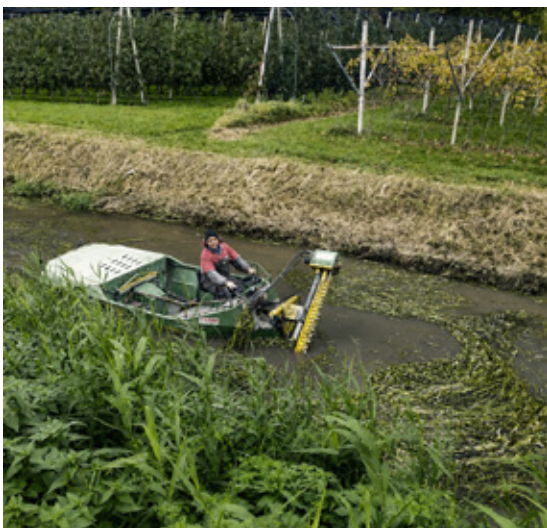
↑ Instandhaltung eines Entwässerungsgrabens
