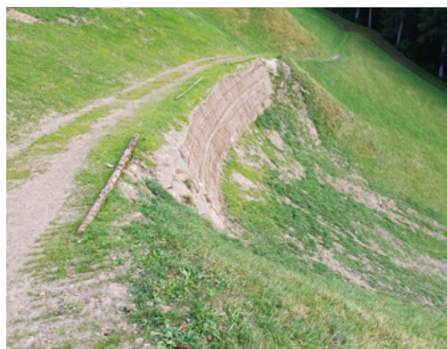
Abbruch Wiesenweg in steilem Gelände ↑
