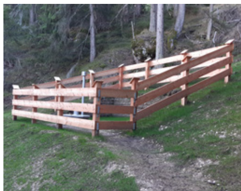
↑ Das Trink- und Löschwassernetz im Land wird laufend Instand gehalten
