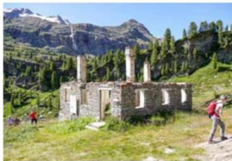
Das Badhaus der Soldaten der Ortler-Cevedale-Front wird wiederhergestellt.
