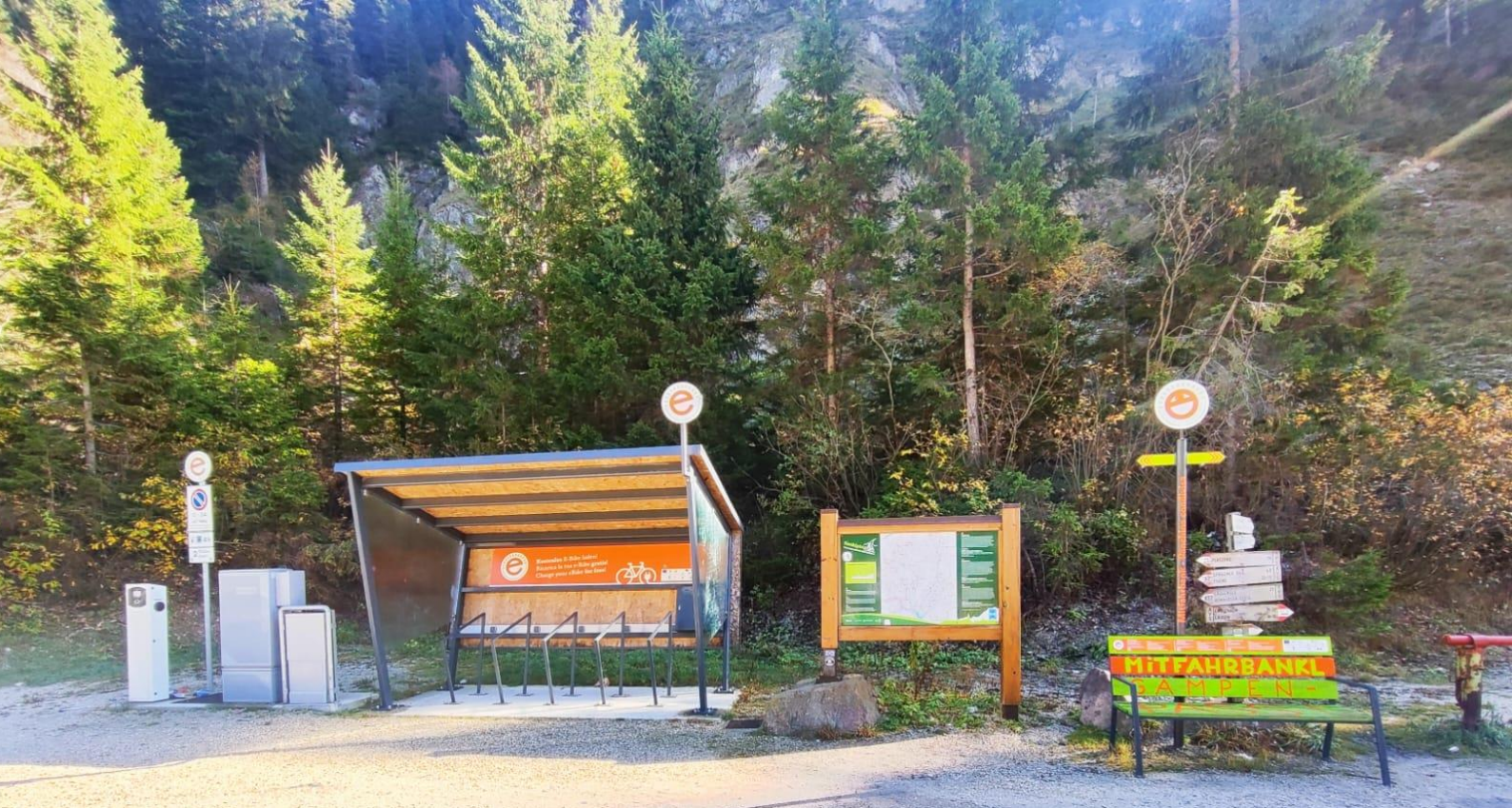
Ladesäulen für E-Autos, Ladestation für E-Bikes und Mitfahrbank am Gampenpass
