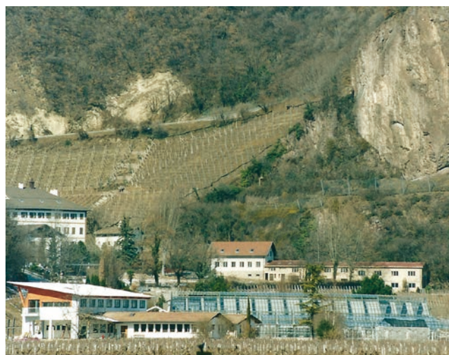
Neubau des Pflanzenschutzgebäudes im Jahre 1999
