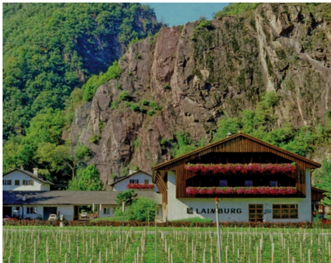
Anfänge des Versuchszentrums: Der Stall wurde später zum Hauptgebäude umgebaut
