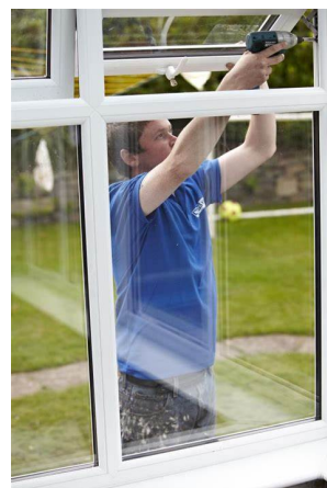
Figura 7: Smontaggio di una finestra
