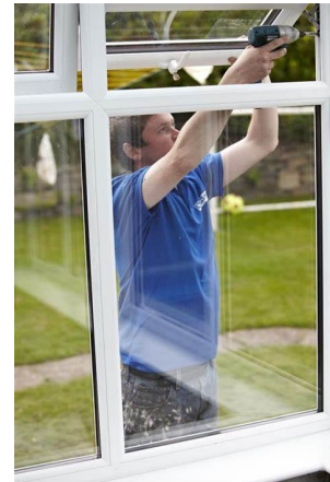
Abbildung 7: Demontage eines Fensters
