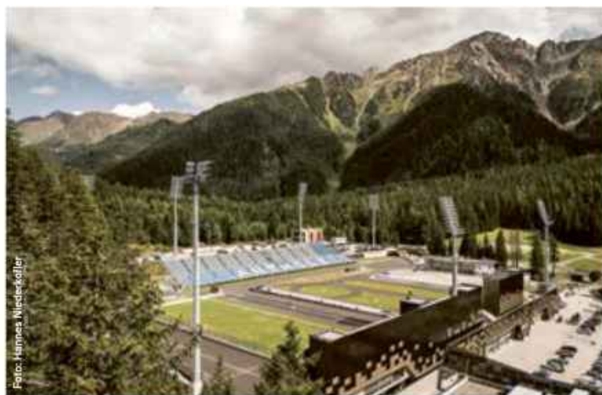
Neue Beleuchtungsanlage: Im Biathlonstadion in Antholz wurden sieben Flutlichttürme mit LED-Strahlern errichtet.
