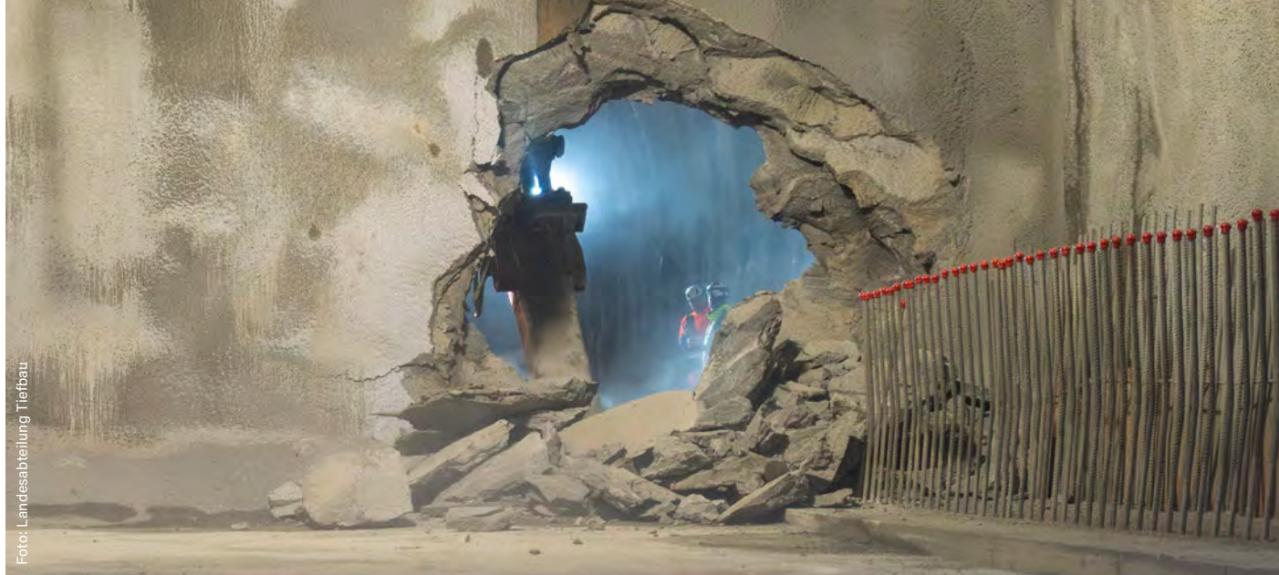
Die Arbeiten am Tunnel der Nordwestumfahrung in Meran gehen planmäßig voran.
