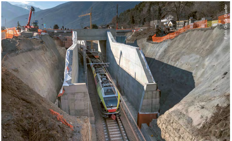
Nella foto, i lavori a Sciaves, nei pressi della stazione che sorgerà e del collegamento in costruzione della variante della Val di Riga. Nel frattempo, hanno ripreso a transitare i treni lungo la ferrovia della Val Pusteria.
