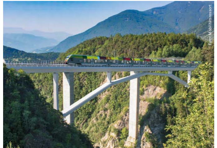
Mit einer 172 Meter langen Bogenbrücke wird die Riggertalschleife den Eisack überqueren.
