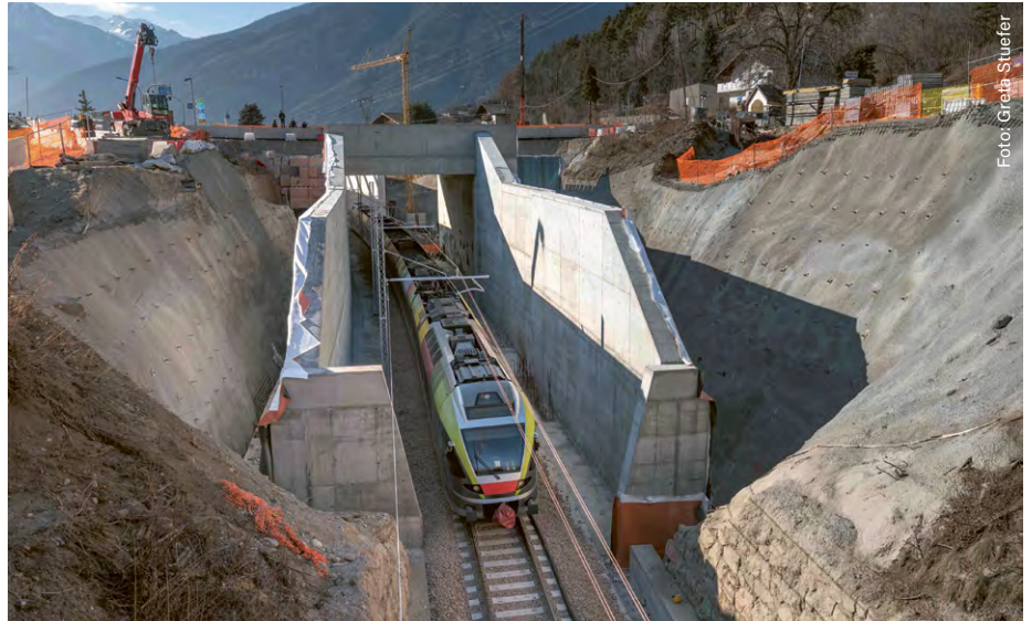
Die Arbeiten in Schabs in der Nähe des künftigen Bahnhofs und an der Riggertalschleife laufen auf Hochtouren. Die Züge der Pustertalbahn verkehren seit 27. Jänner wieder.
