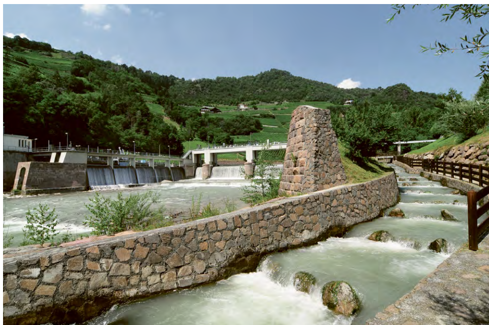
Südtirol betritt Neuland bei der Ausschreibung von Großkraftwerken: Sieben Konzessionen, darunter jene des Kraftwerks Waidbruck-Barbian (im Bild), sind neu zu vergeben.
