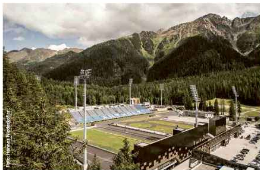
Illuminazione garantita: alla Olympic Arena sono state installate sette nuove torri faro con proiettori a LED.
