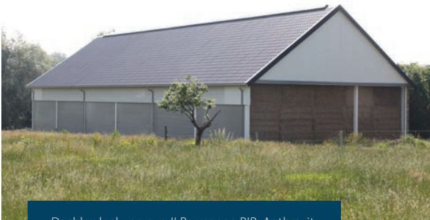
Dachbedeckung aus JI Permapan PIR, Anthrazit.
