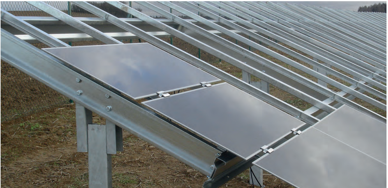
Gordingconstructie gebruikt in combinatie met zonnepanelen
