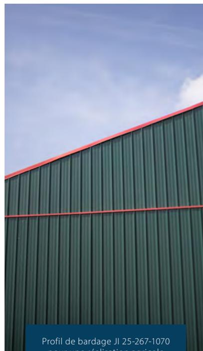
Profil de bardage JI 25-267-1070 pour une réalisation agricole
