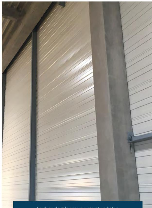
Bardage double peau sur structure béton
