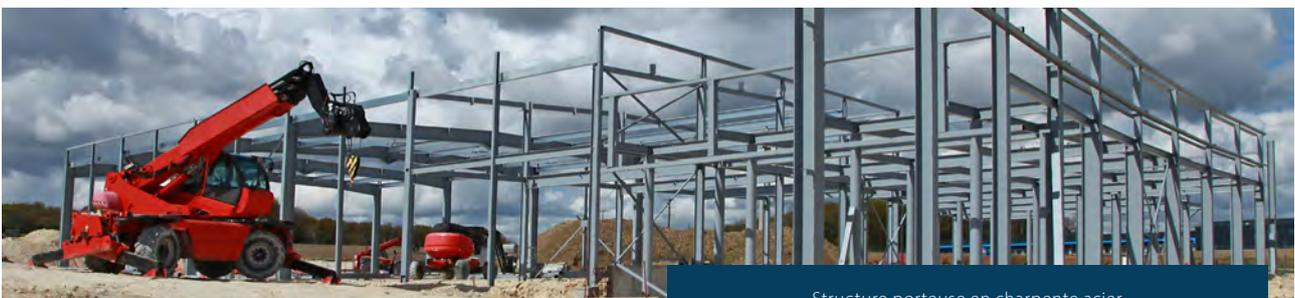
Structure porteuse en charpente acier
