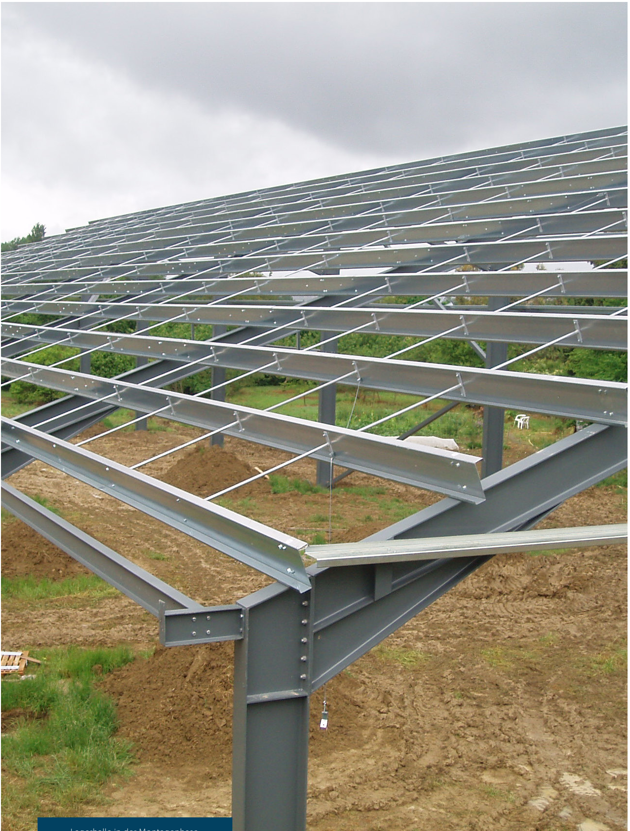
Lagerhalle in der Montagephase.
