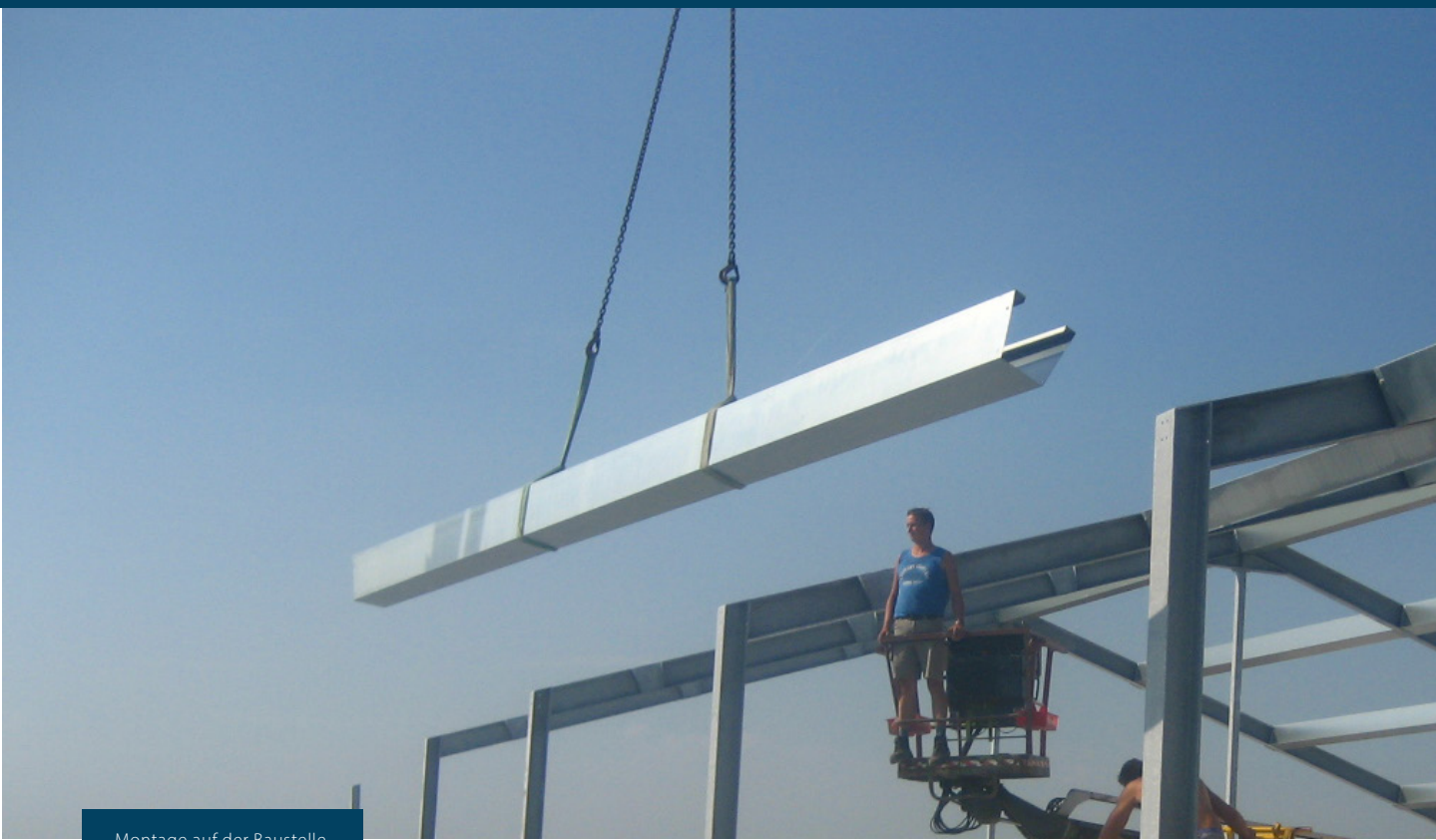
Montage auf der Baustelle.
