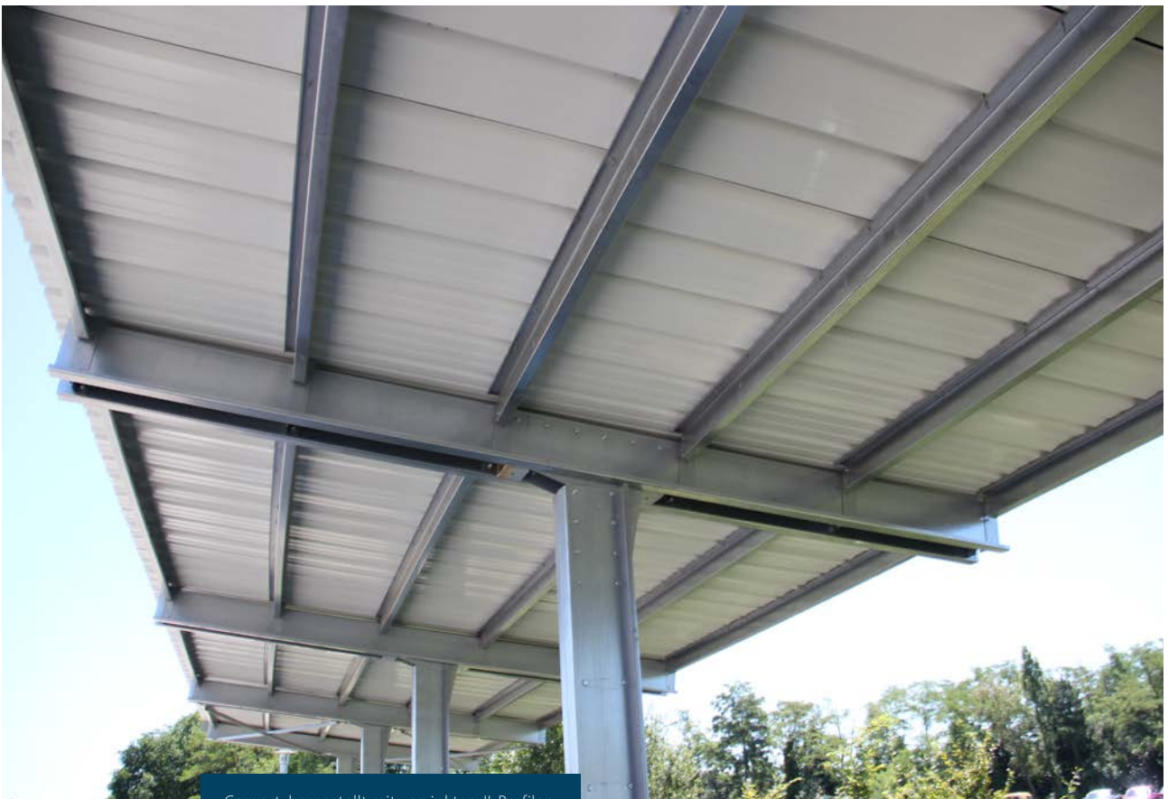
Carport, hergestellt mit verzinkten JI-Profilen.
