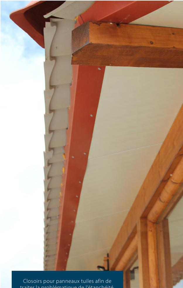
Closoirs pour panneaux tuiles afin de traiter la problématique de l'étanchéité.
