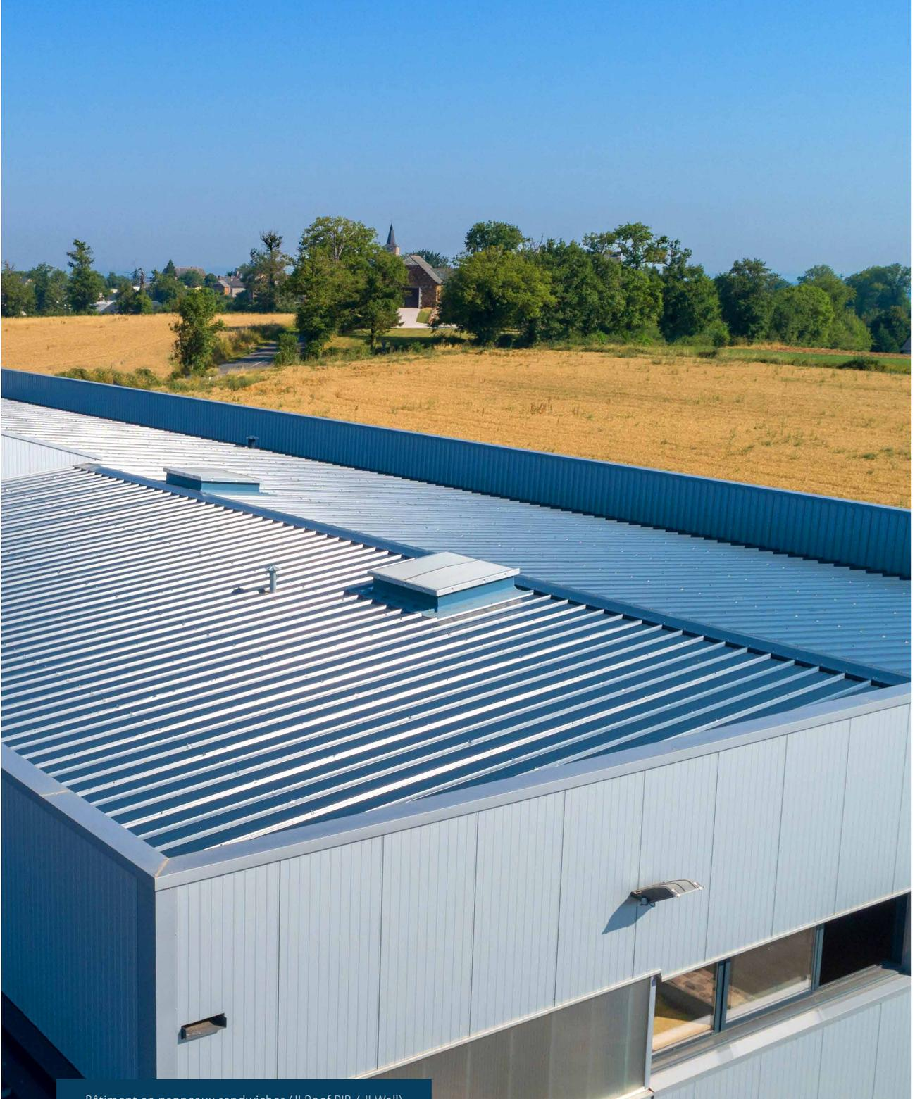
Bâtiment en panneaux sandwichs (JI Roof PIR / JI Wall)
