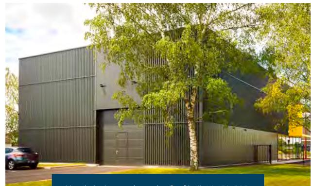
Vertikale Anwendung des Profils JI 46-150-900.
