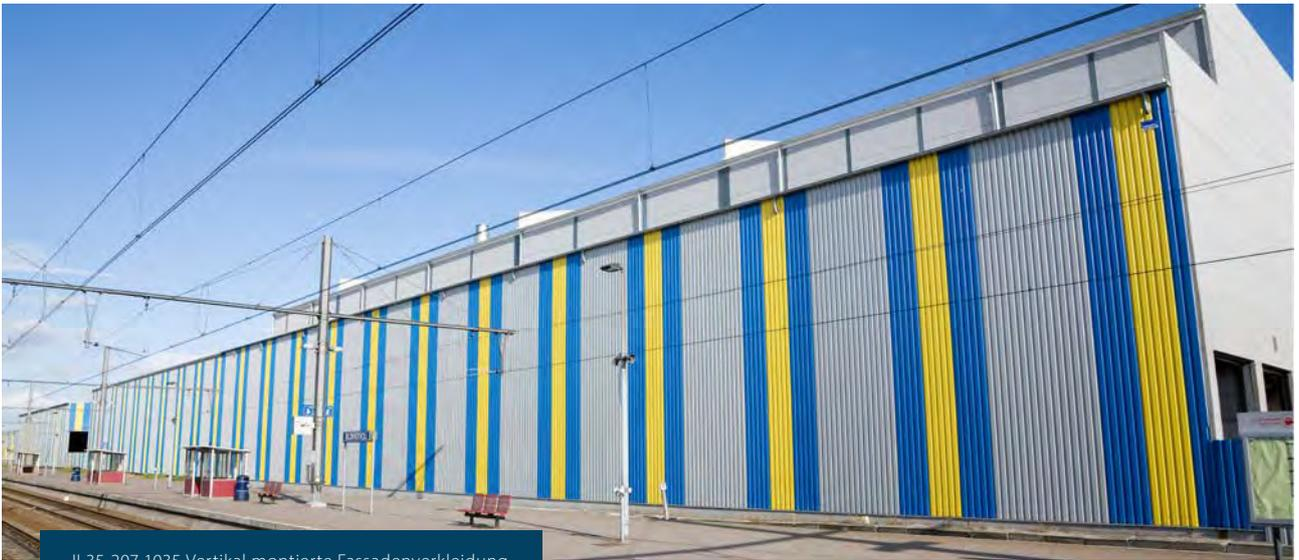
Jl 35-207-1035 Vertikal montierte Fassadenverkleidung.
