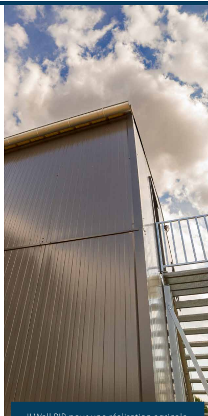
Jl Wall PIR pour une réalisation agricole.
