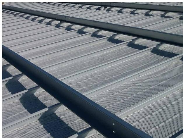
Les fausses pannes peuvent répondre aux prescriptions du § 5.3.1 du DTU 40.35 et se fixent par boulonnage sur les échantignoles préalablement posées. Ces échantignoles peuvent être également fixées par boulonnage, ou vissage dédié au-travers du plateau ou directement à la charpente; le plateau ayant été préalablement découpé. Nous consulter pour plus d'informations sur cette étape.
